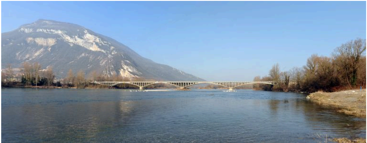
Vue panoramique, face aval (depuis la rive gauche)
