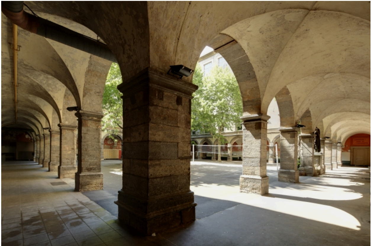
Cour du lycée. Galeries intérieures depuis l'angle sud-est.
