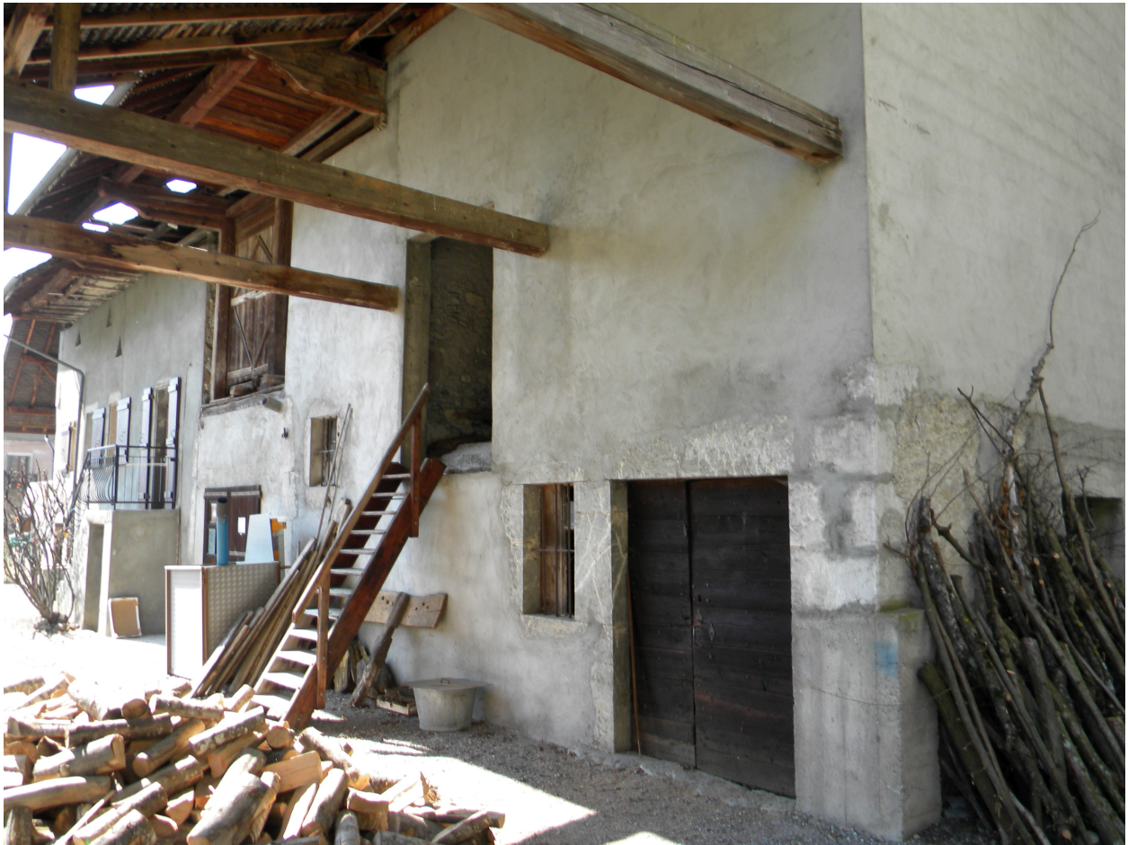
Vue des entrées d'étable, de grange et de fenil sur la façade principale.
