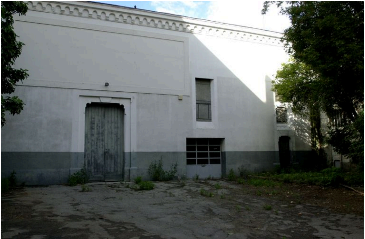
Chapelle, élévation sud sur cour, partie droite
