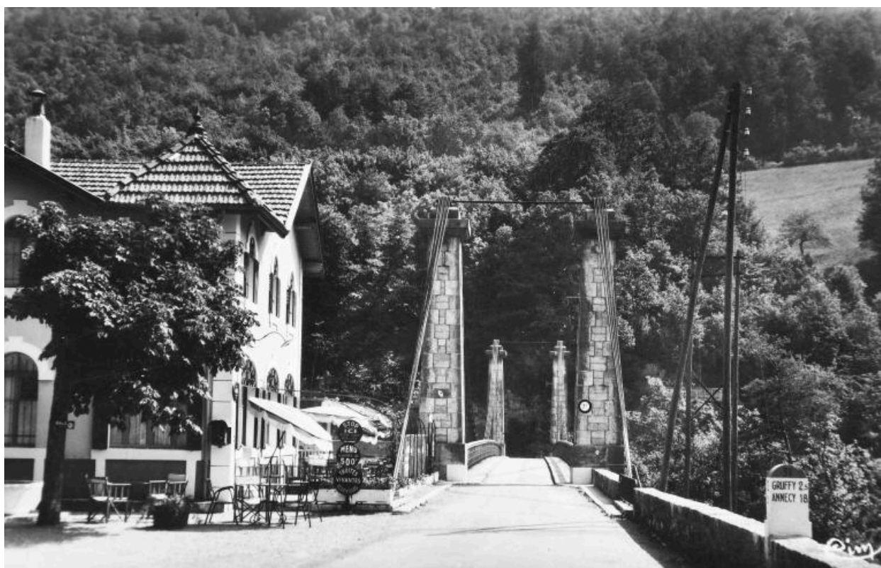
1 – Le Pont de l'Abîme (haut. 95 m.) [1962]
