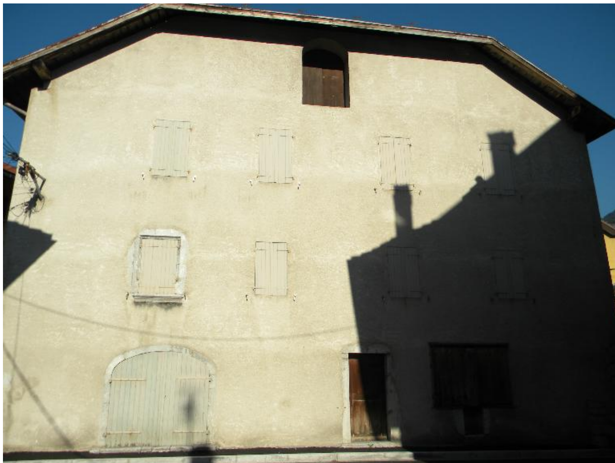
Façade principale d'un immeuble à l'angle des rues Nicolas Blanc et Léon Gambetta (2008 D15 2490).
