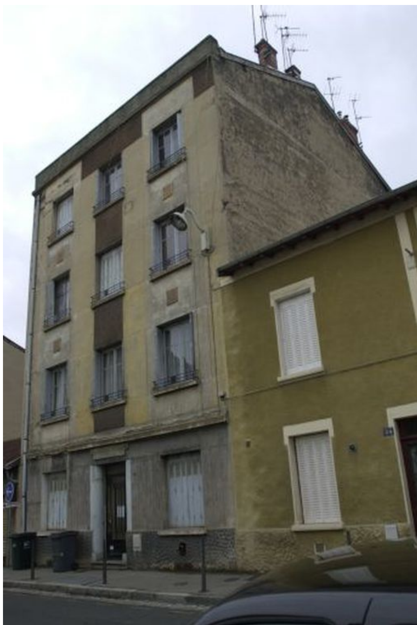
Vue générale de l'élévation depuis le sud-ouest
