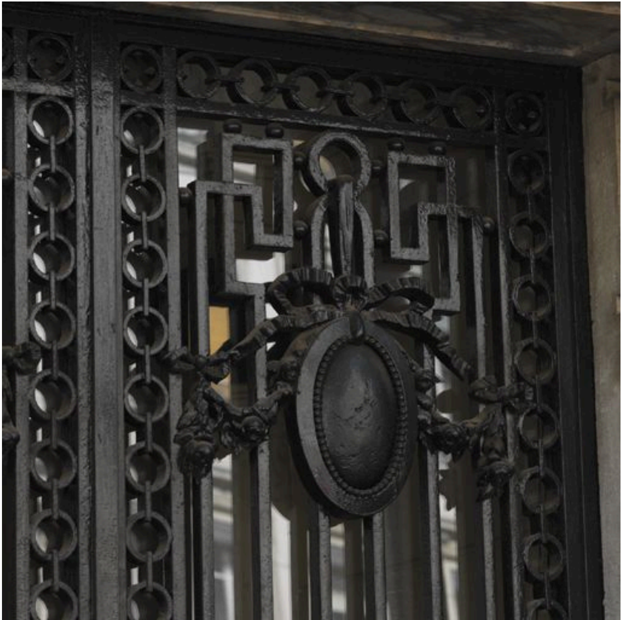
Détail de la grille de la porte d'entrée
