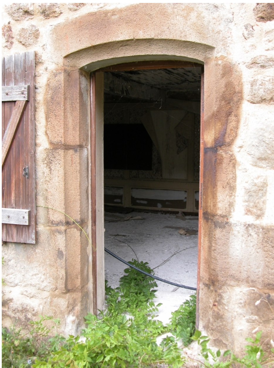
Façade sud, partie ouest, détail de la porte d'entrée.
