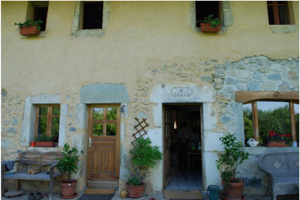
Bâtiment principal, détail de la façade antérieure : ouvertures du logis.
