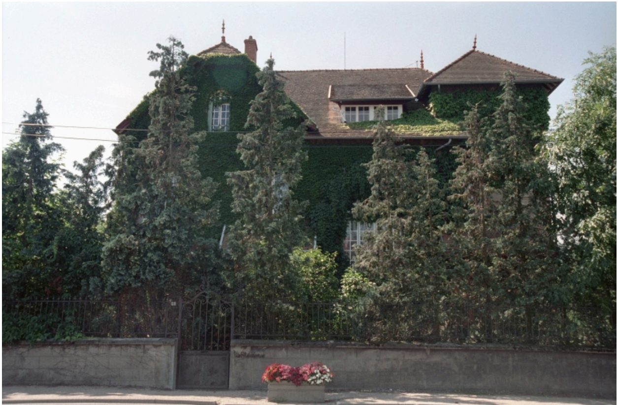
Boën, îlot 13, RN 89, 21. Vue générale de la façade sur rue.
