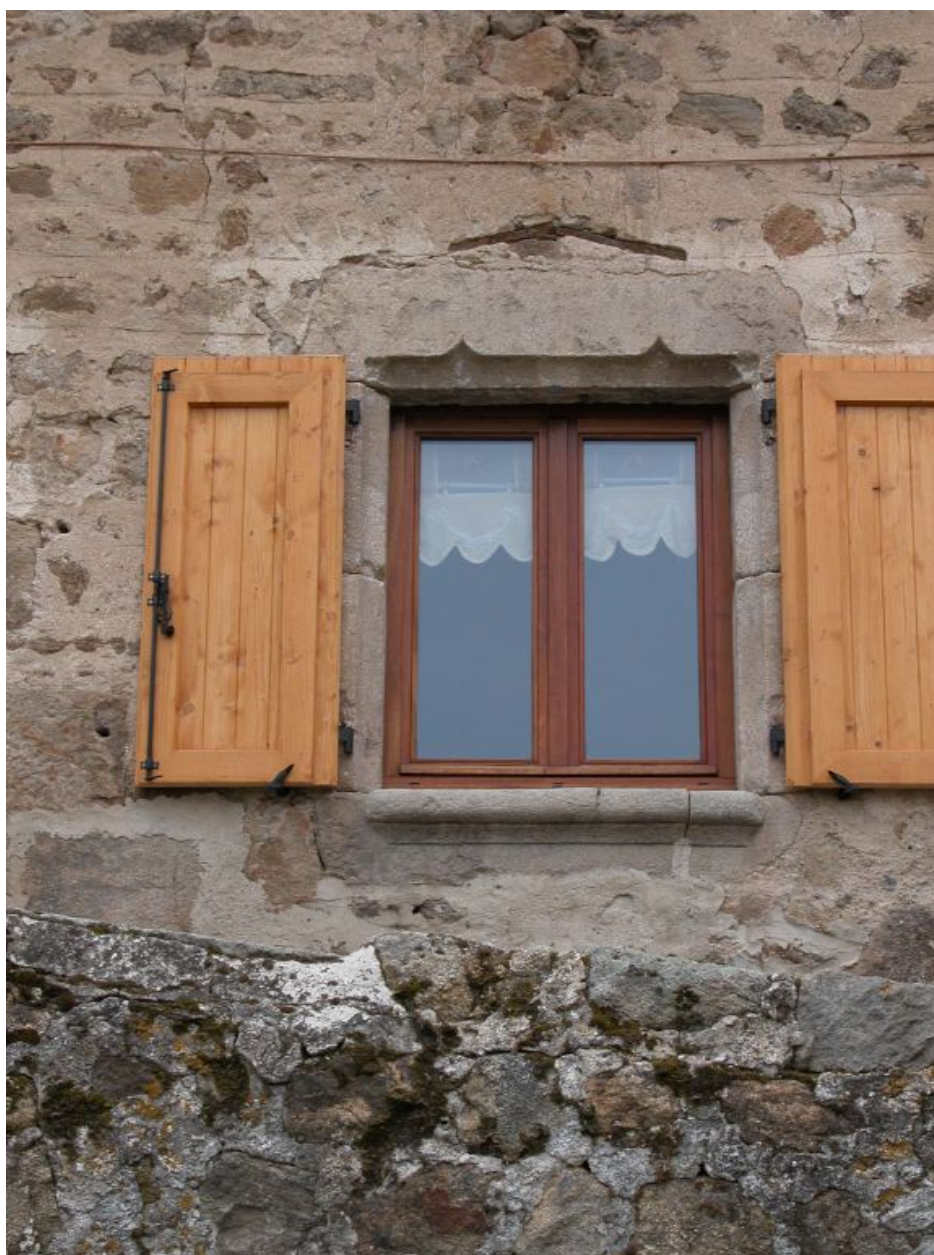
Logis, détail d'une baie du rez-de-chaussée surélevé.
