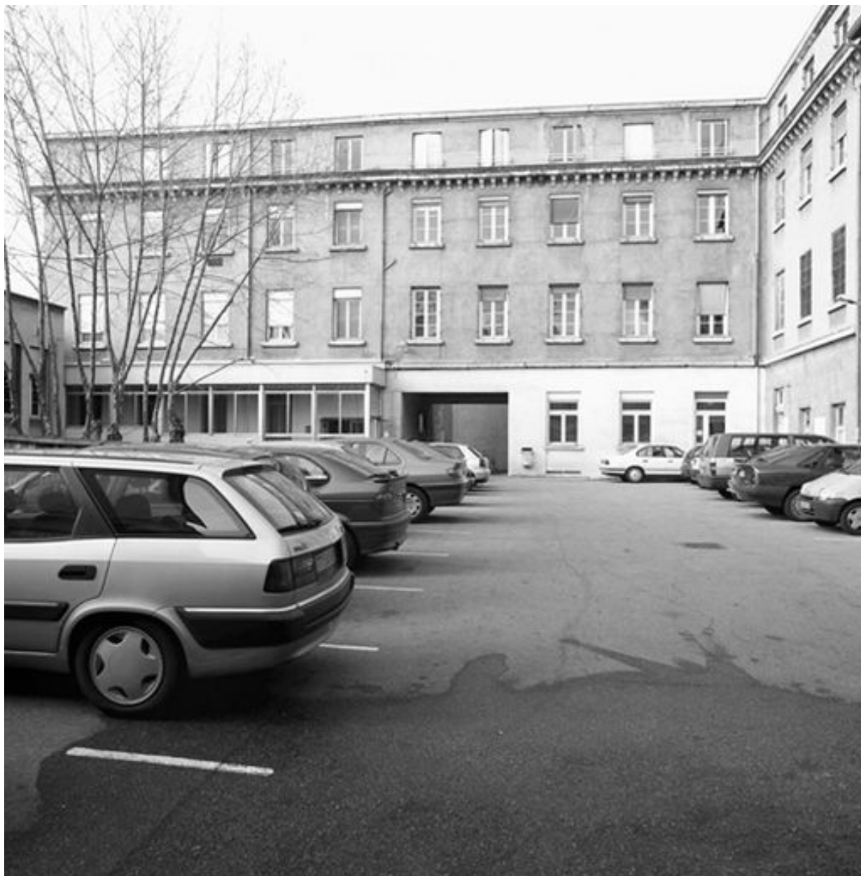
Bâtiment 9, vue générale des façades sur les terrasses 11 et 10
