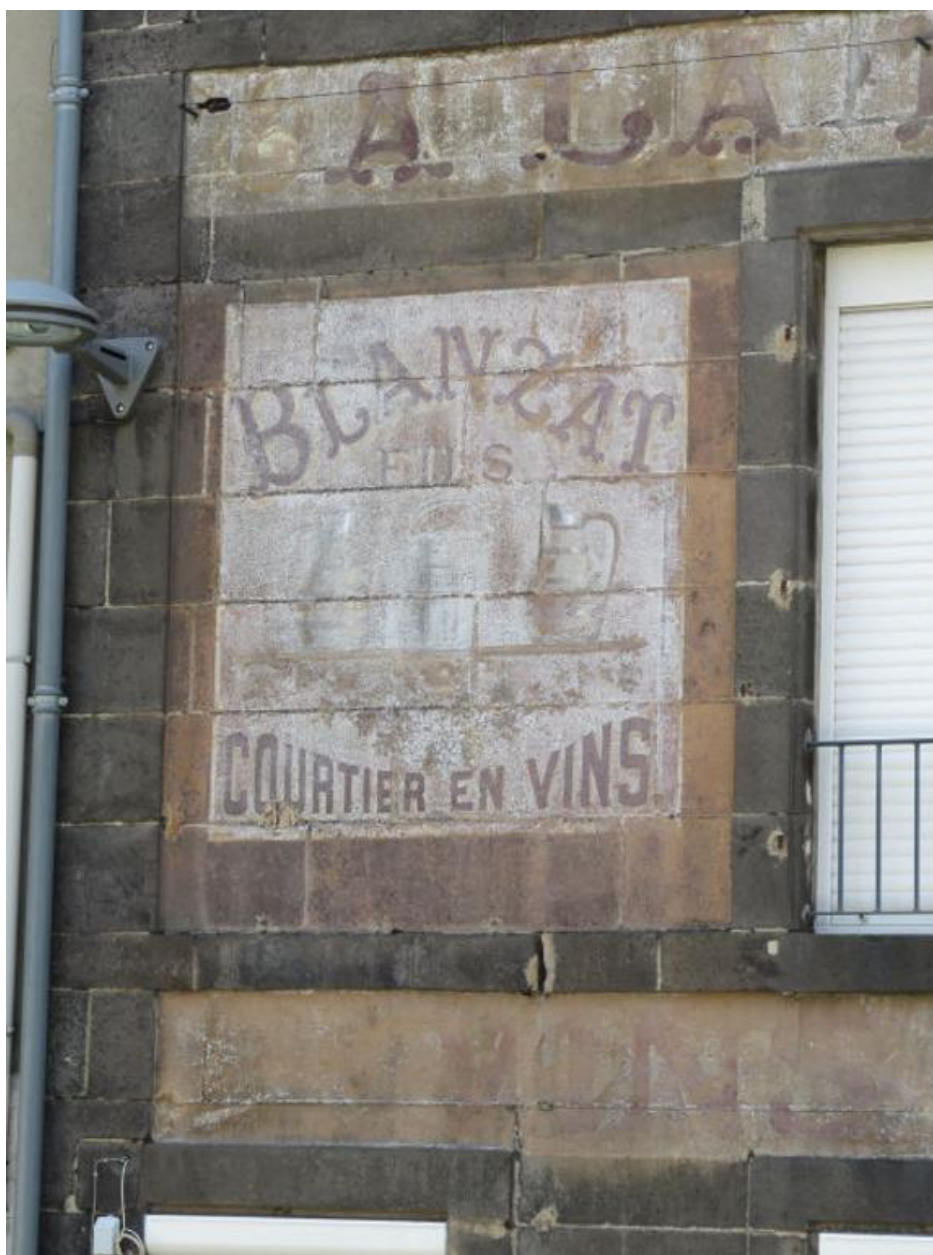
Maison de courtier en vins, Blanzat, vue de détail : enseigne peinte
