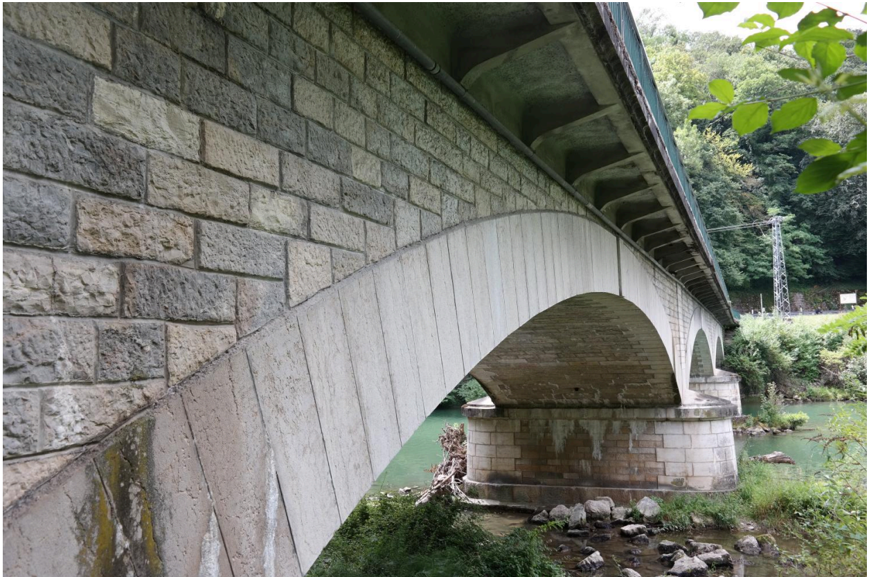
Pont du Fier. Détail d'une pile.
