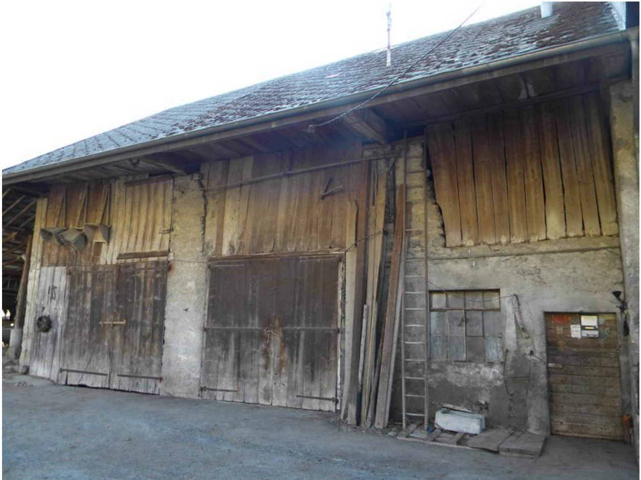
Façade principale du bâtiment agricole.
