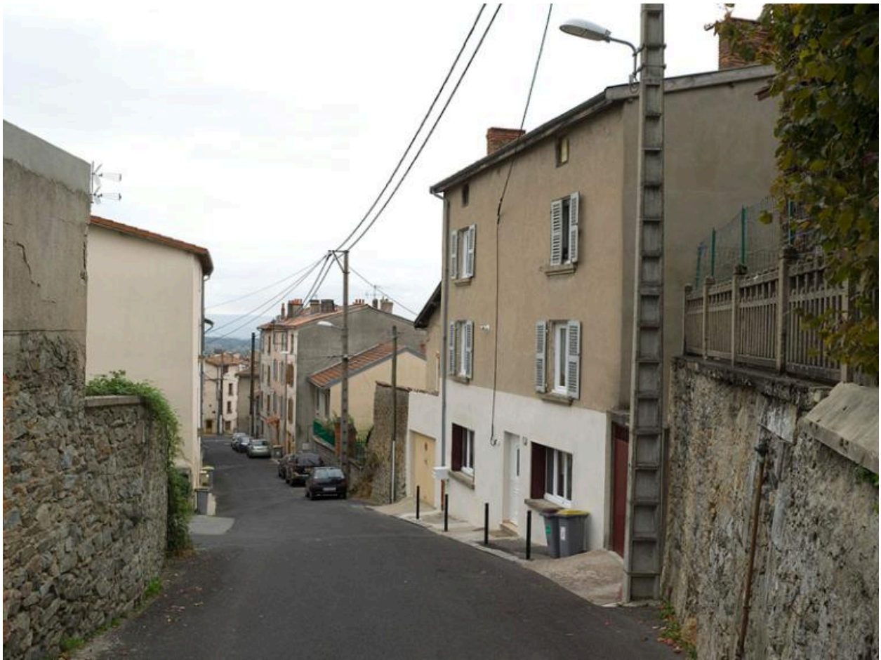
La rue dans le sens de la descente, en direction du sud-ouest.
