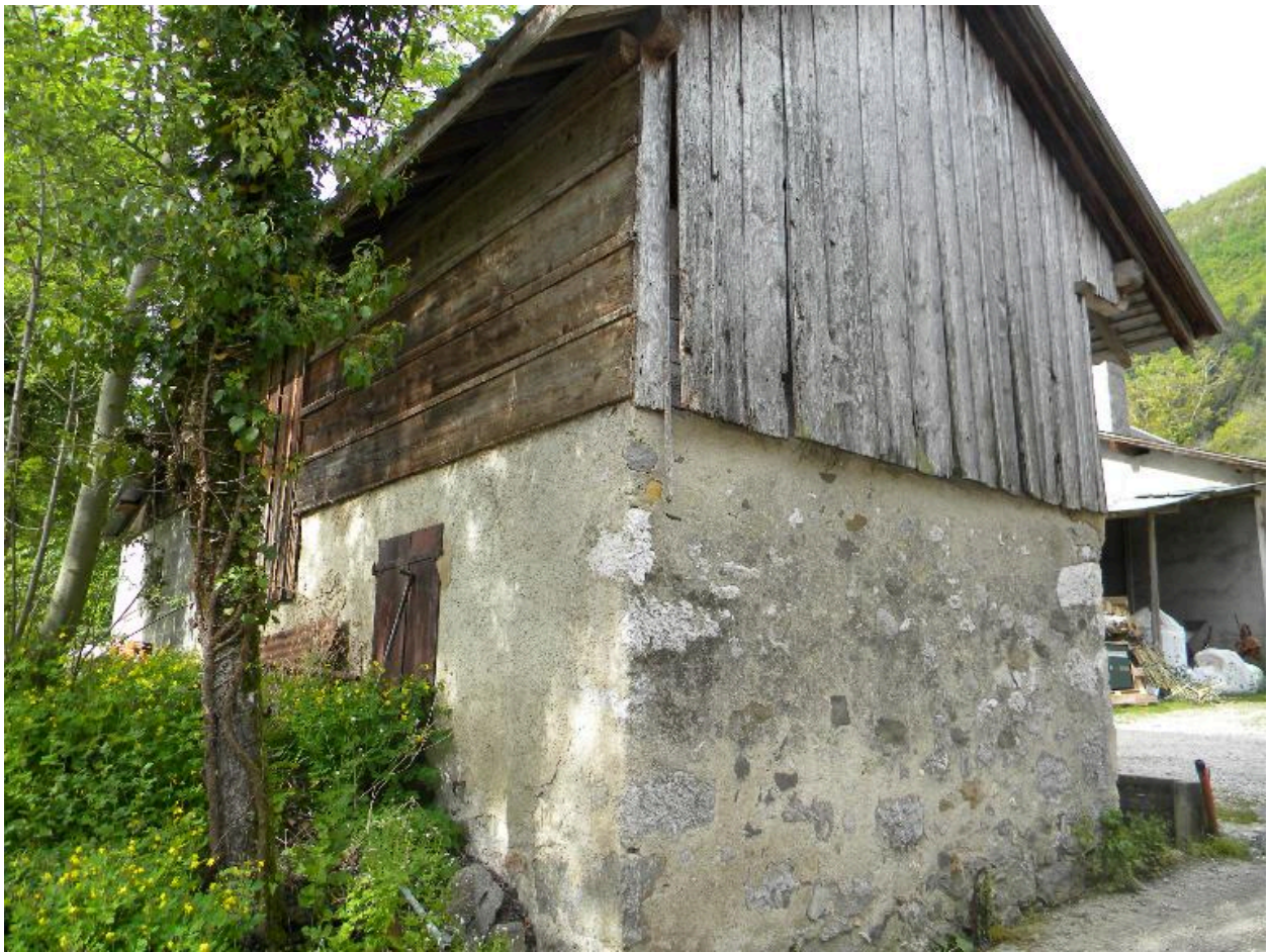
Vue de trois quarts d'une annexe agricole.
