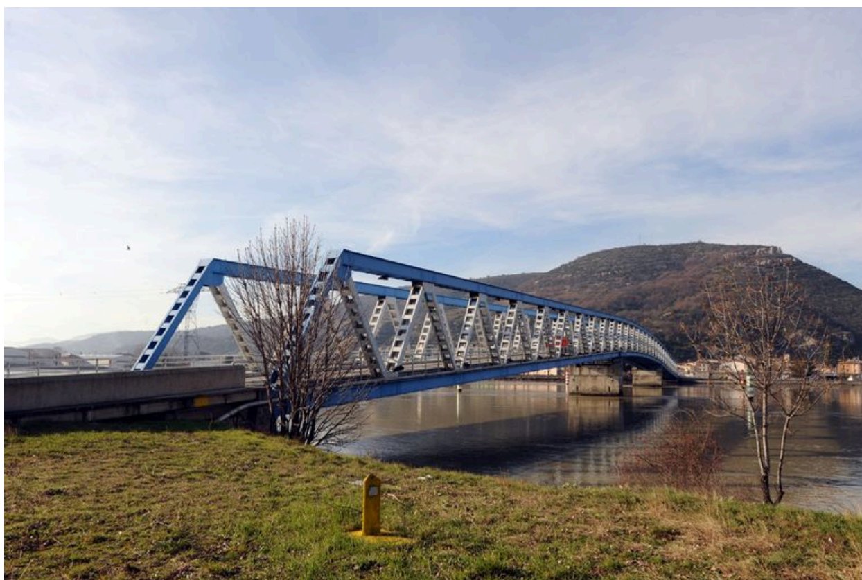
Vue générale, de côté, face amont (depuis la rive gauche)
