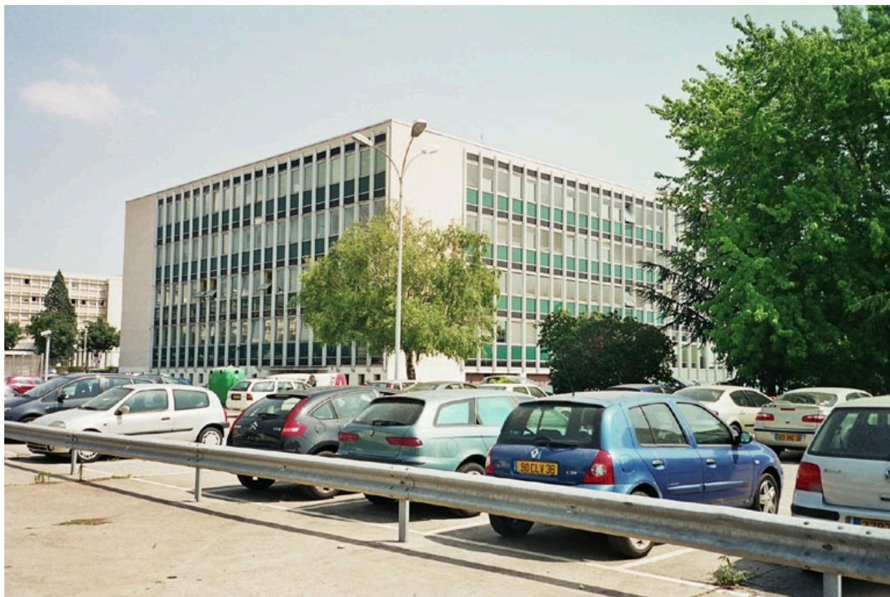
Vue d'ensemble du bâtiment administratif construit en 1964
