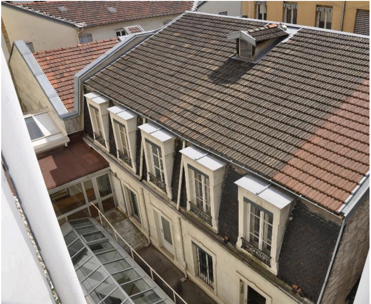
Vue partielle de l'immeuble sur cour, depuis le nord
