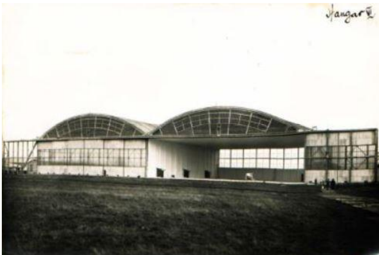
Hangar VI photo chantier ETs. Boussiron 1925 (ADR : 4535W47)
