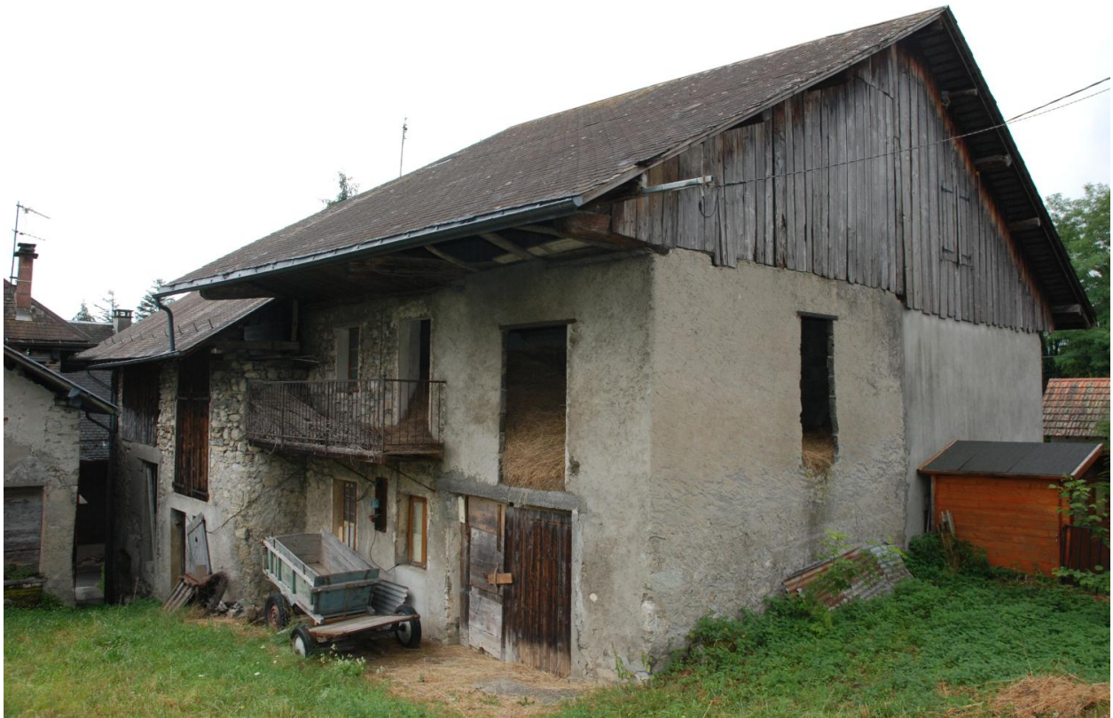
Maison, ferme (2018 E3 992, 990). Vue du nord-est.
