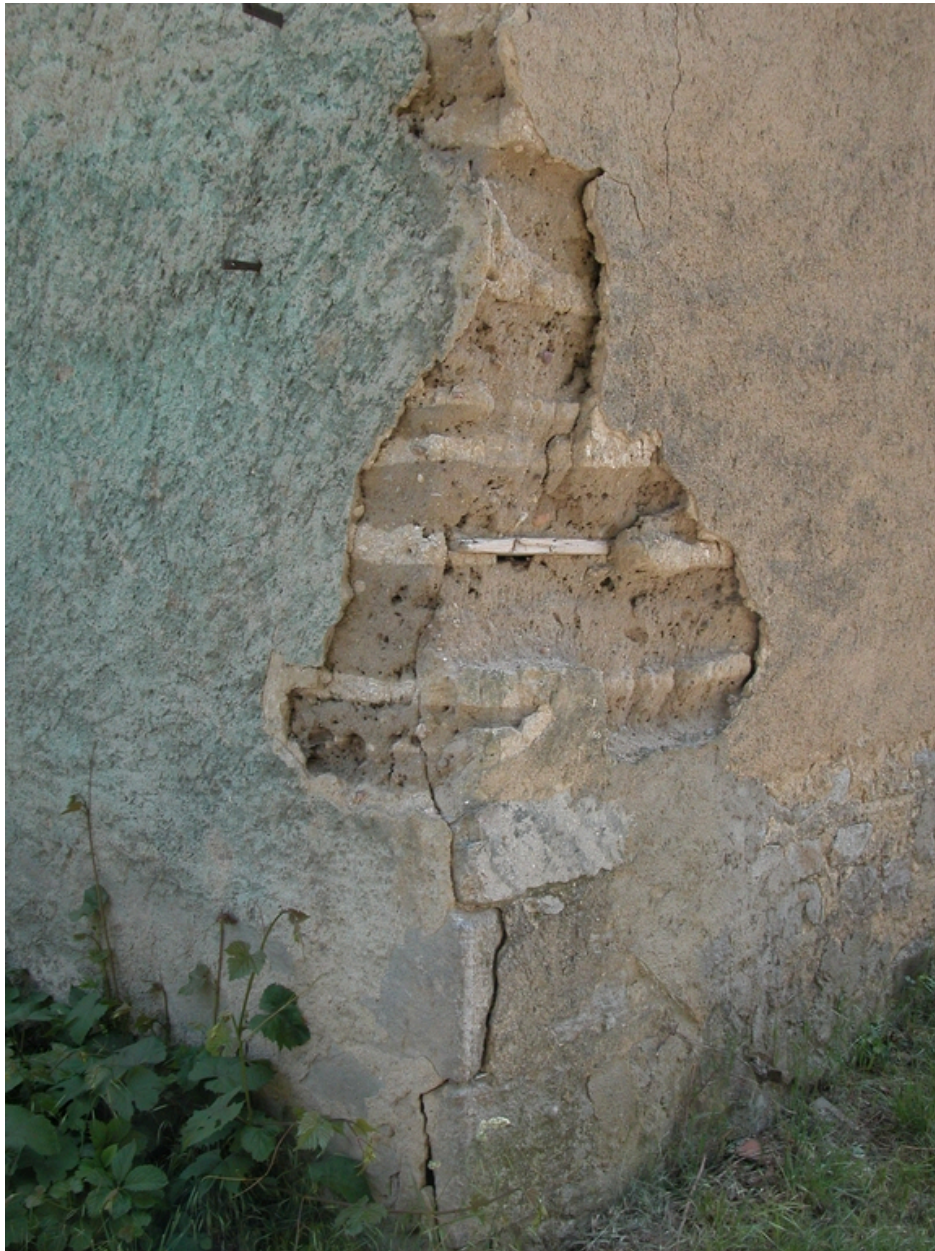
Détail d'un angle en pisé.
