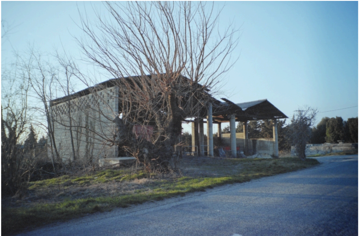
Les Plans, ancienne distillerie de lavande, aujourd'hui désaffectée.
