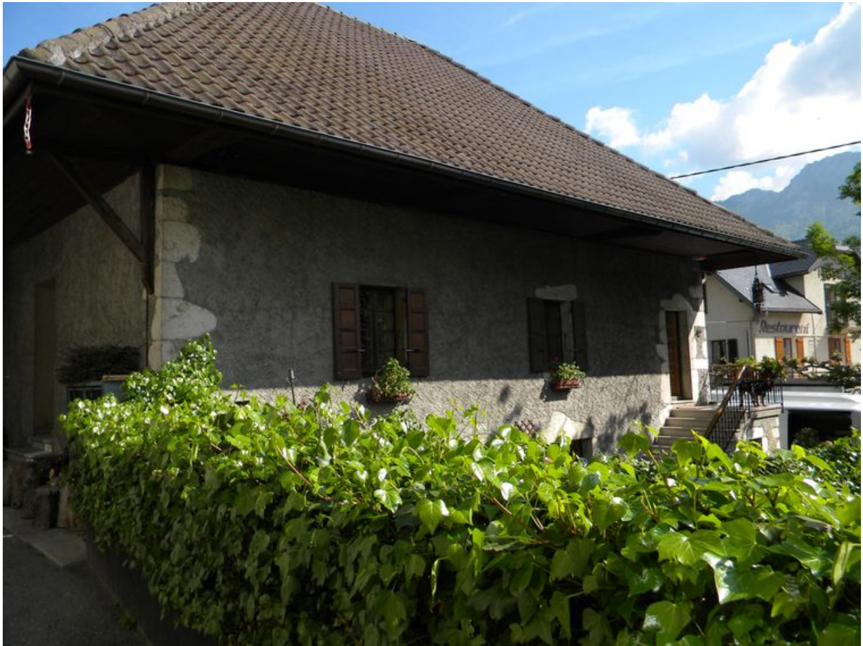
Façade sud d'une ancienne grange (2008 A3 360).
