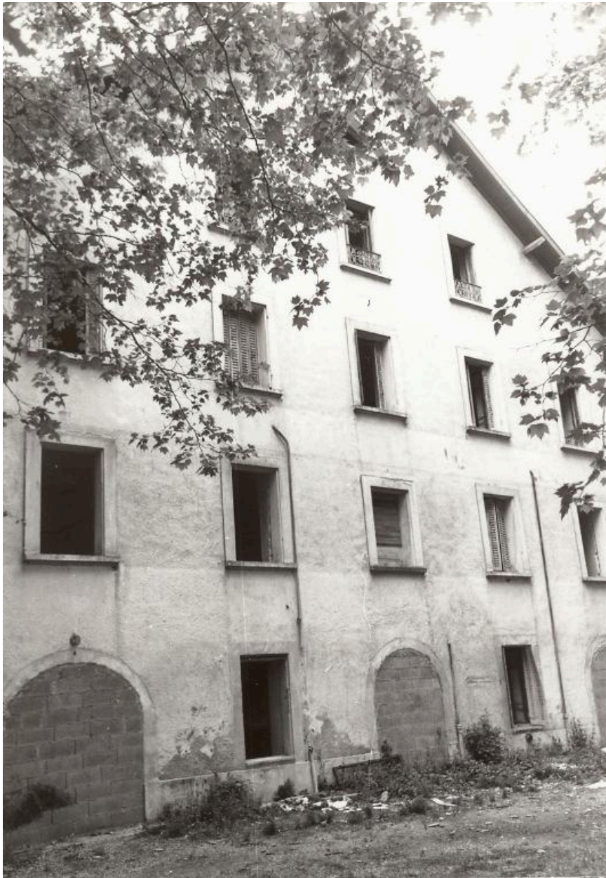
Pignon avant démolition, 1982
