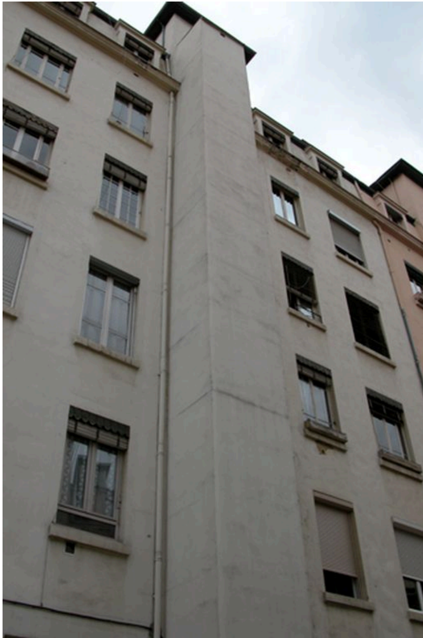
Colonne d'ascenseur rajouté sur l'élévation sur cour
