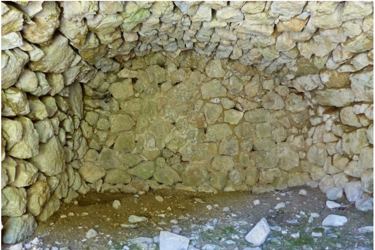
Vue de volume d'une étable, entrepôt agricole au quartier de la Combe.
