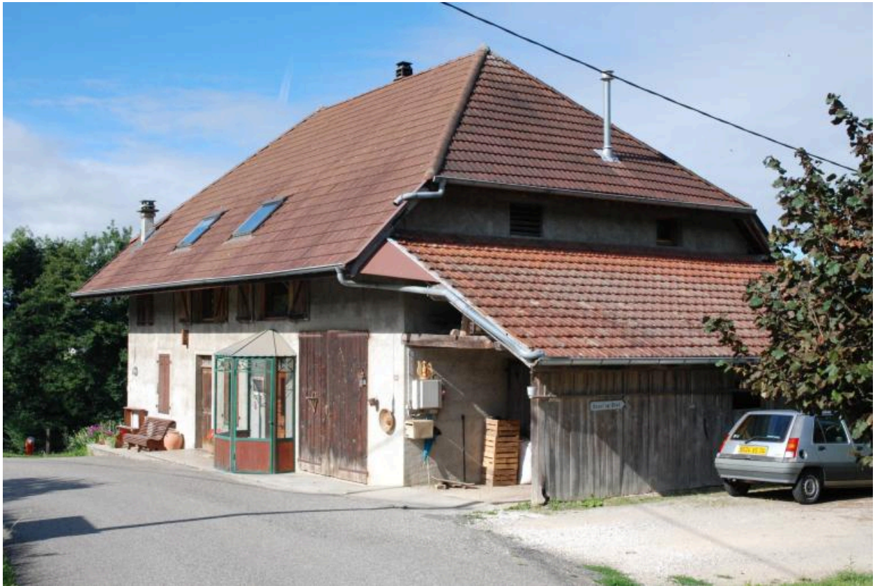
Vue de l'atelier de menuiserie, depuis le nord-est.
