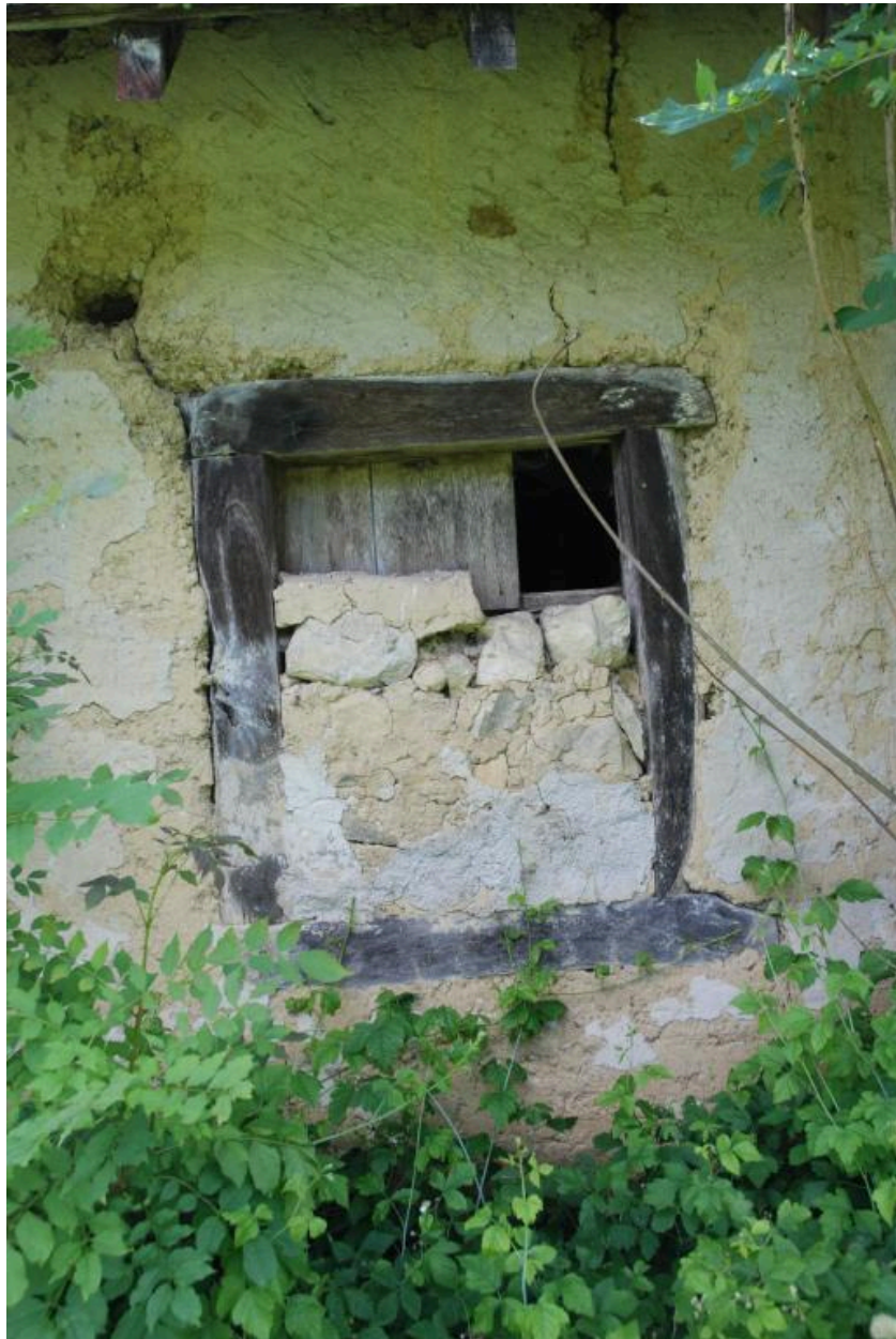
Détail d'ouverture : fenêtre murée.
