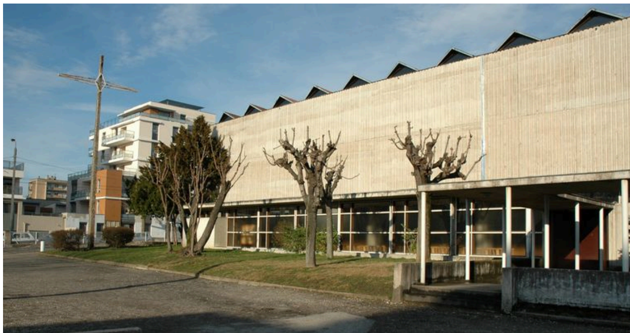
Élévation latérale ouest depuis le sud-ouest
