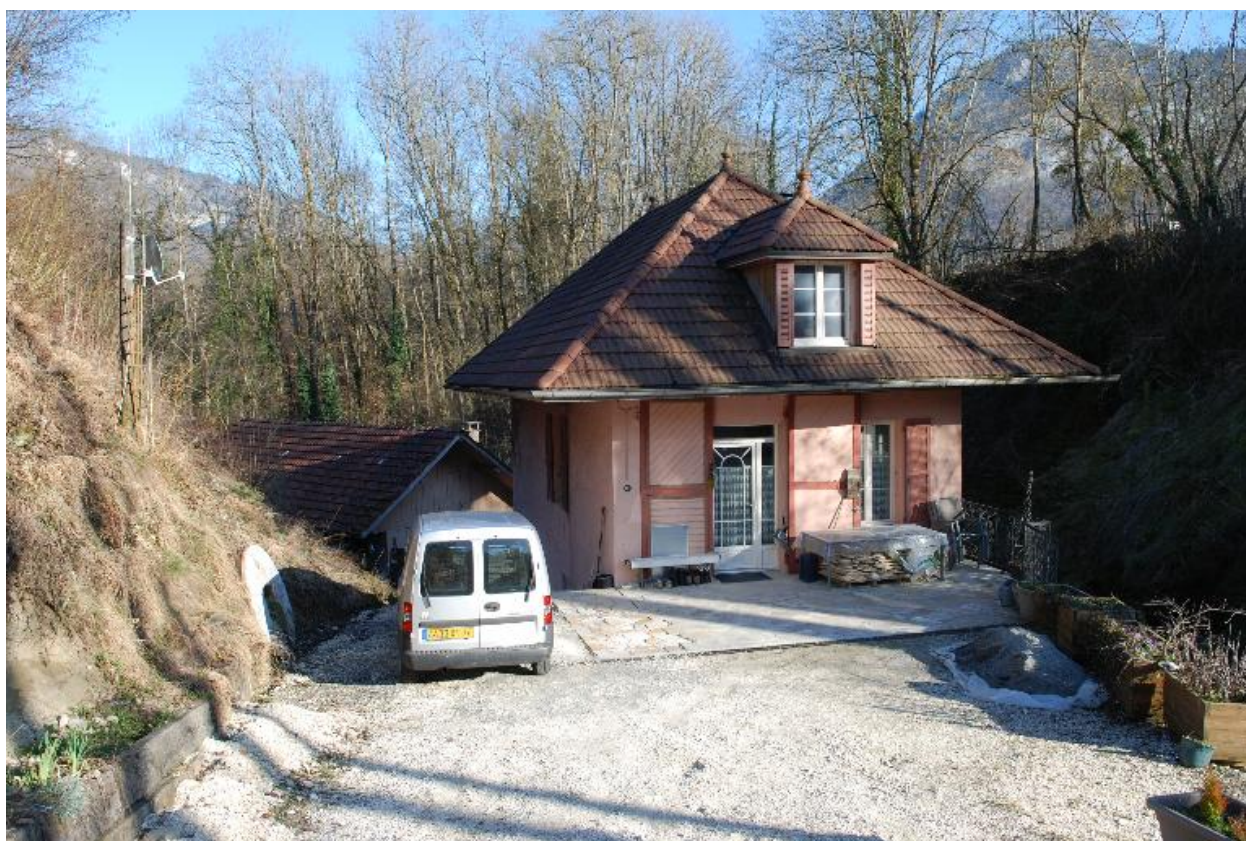
Vue d'ensemble des moulins.
