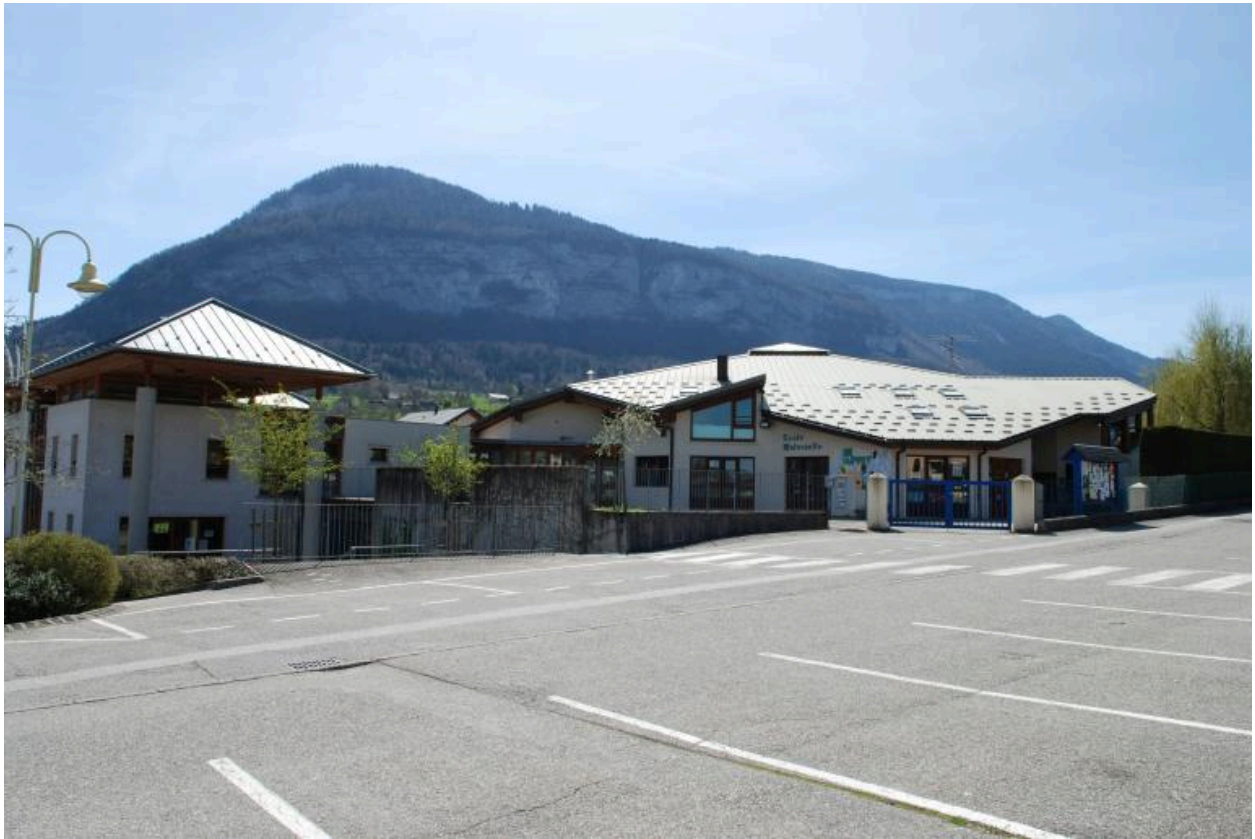
Fay-Est (le), B3 1739, ensemble scolaire. Vue d'ensemble.
