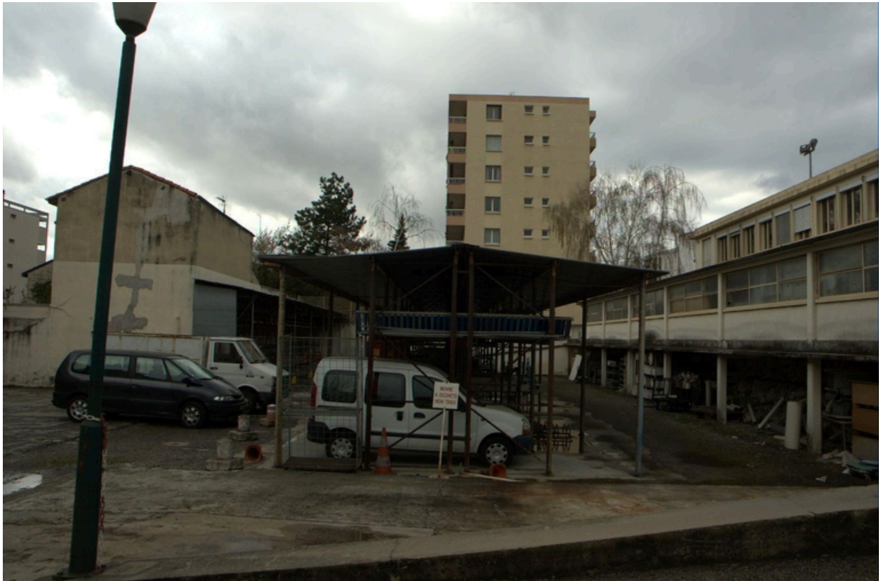
Vue d'ensemble des espaces techniques
