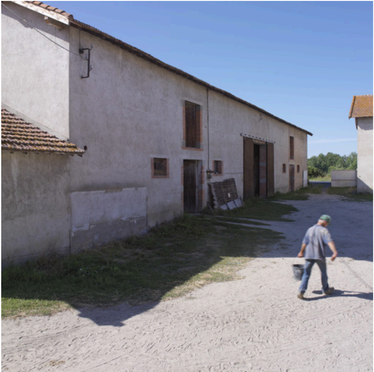
Vue de la double grange-étable, depuis le sud-est.
