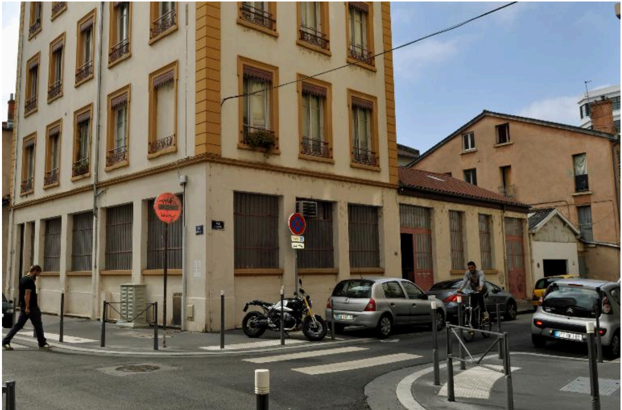
Vue rapprochée du rez-de-chaussée de l'immeuble, avec atelier en continuité
