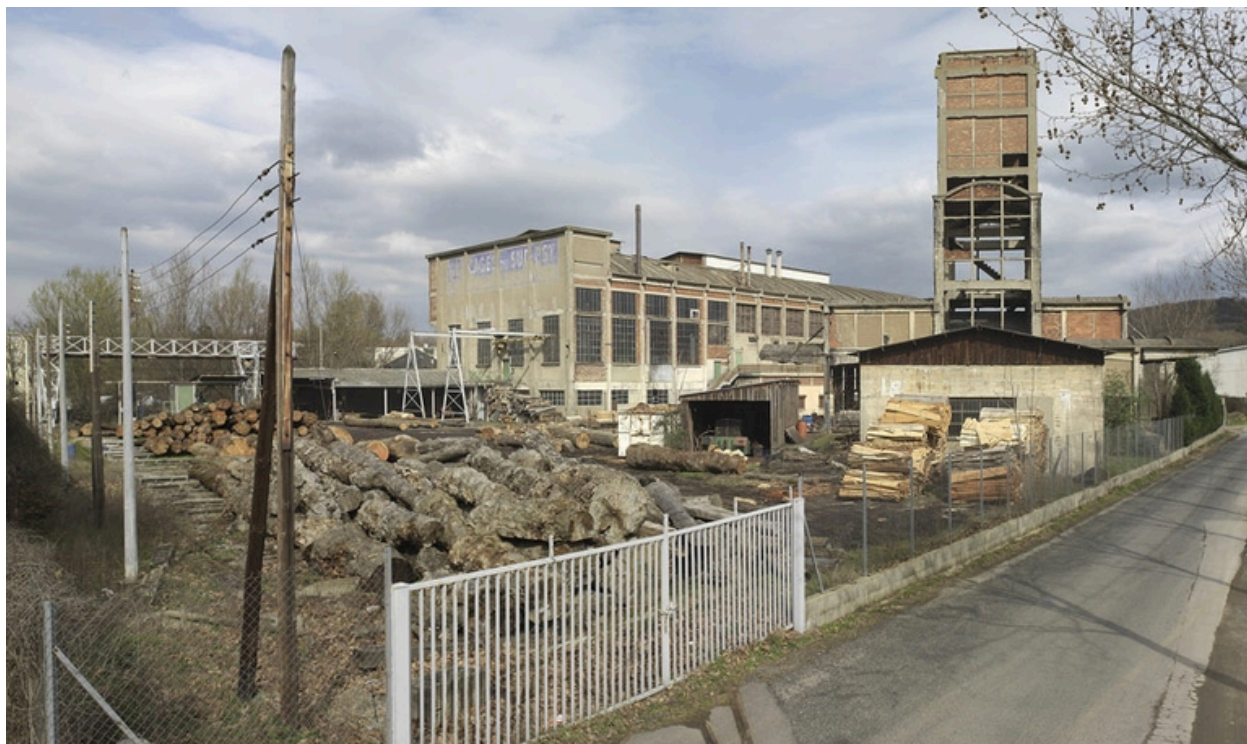
Vue d'ensemble ouest
