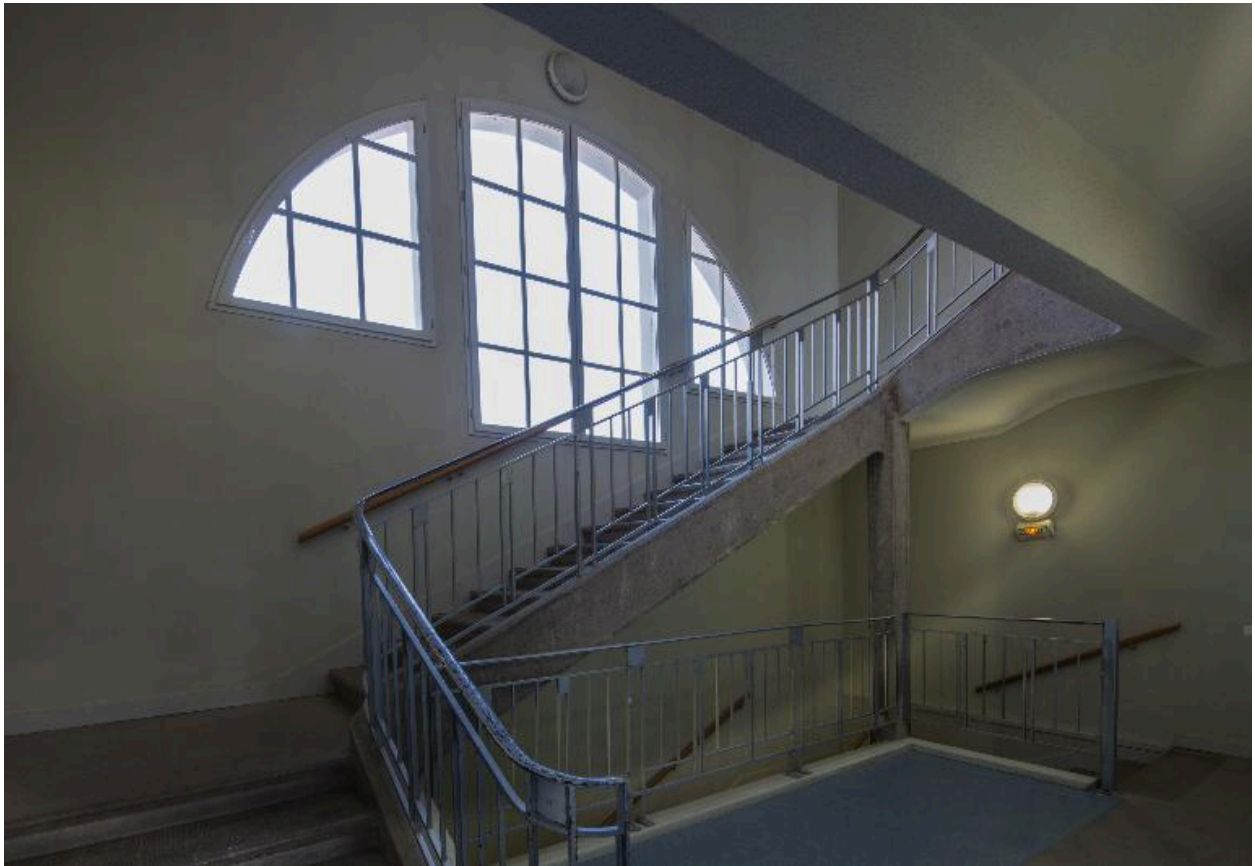
Bât. A : escalier au nord de l'aile est, 1er palier
