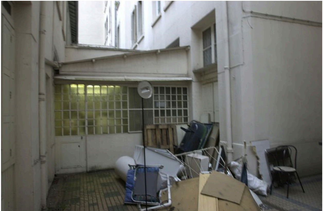
Vue de la cour et du bâtiment A vers le sud
