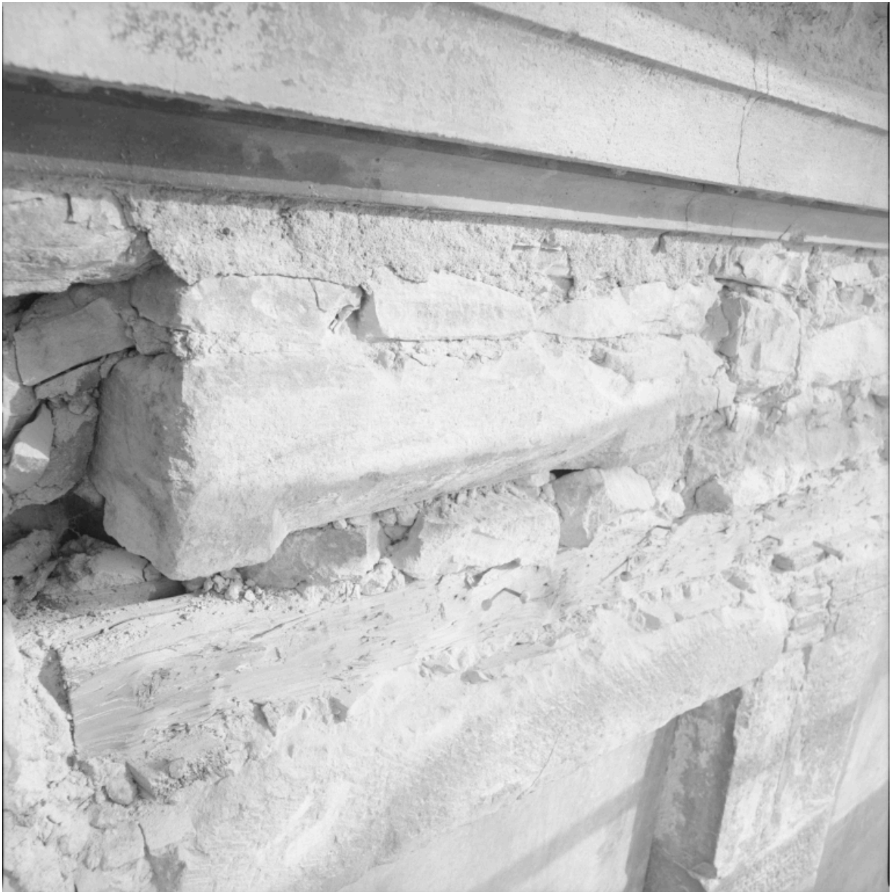
Etude archéologique de la façade principale : niveau 1. Remploi de linteau chanfreiné (a).
