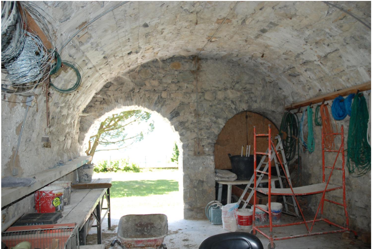
Bâtiment de dépendances, étage de soubassement, vue intérieure : avant-dernière cave.
