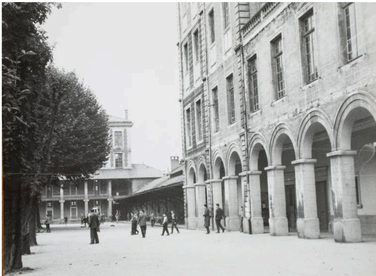
Vue de la galerie du bâtiment H et du préau, vers 1950 (Arch. mun. Roanne, sans cote)
