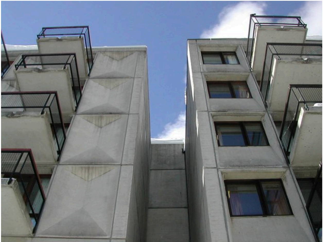
Détail de la jonction entre l'hôtel et la résidence. Les étages
