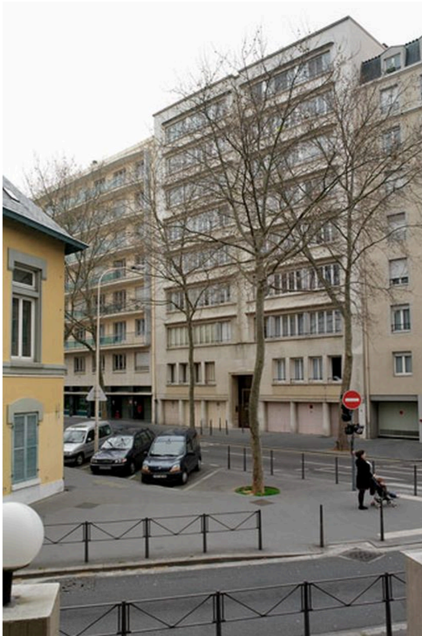
Vue générale depuis le nord-ouest
