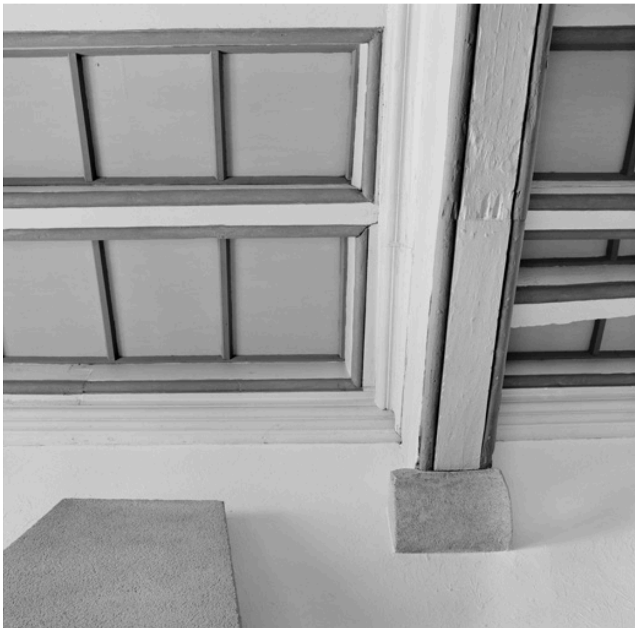
Vue partielle du plafond à caissons du 1er étage.
