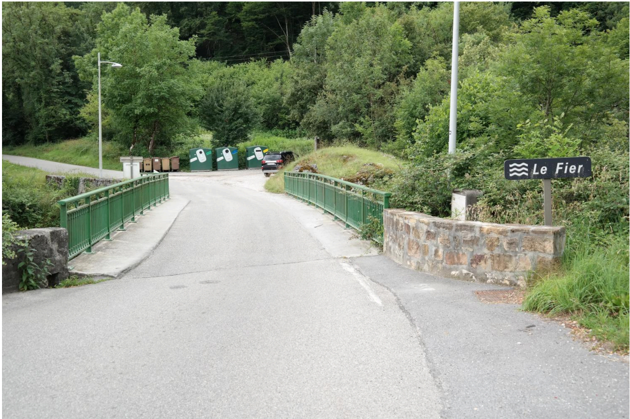
Pont Saint-André, vue de la chaussée depuis la rive droite
