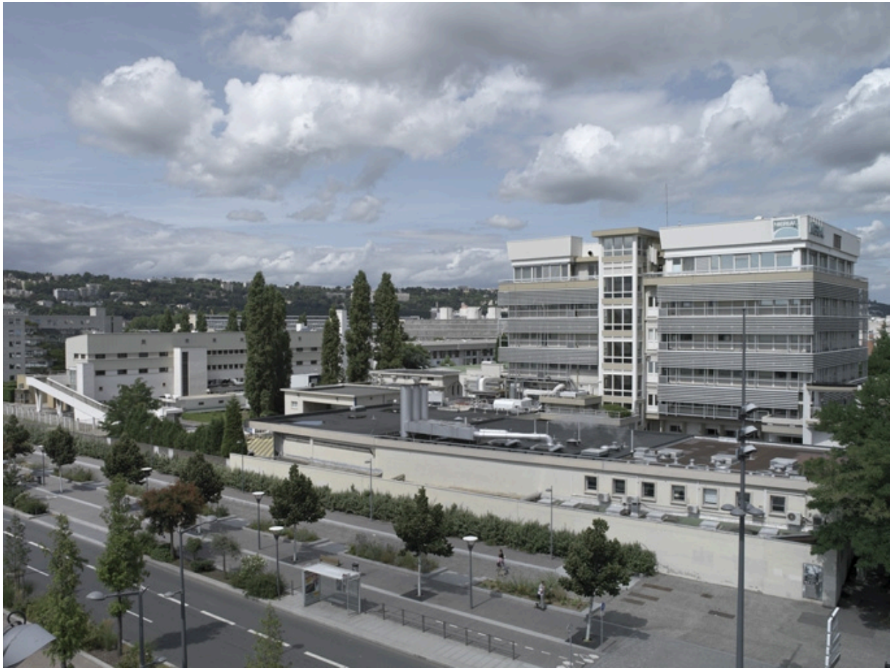
Vue d'ensemble sud
