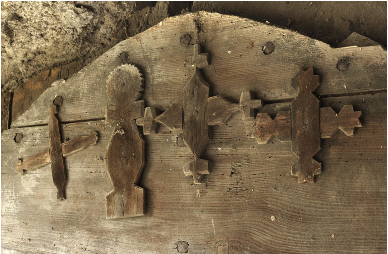
Détail du vantaill de la porte du logis : croisettes.
