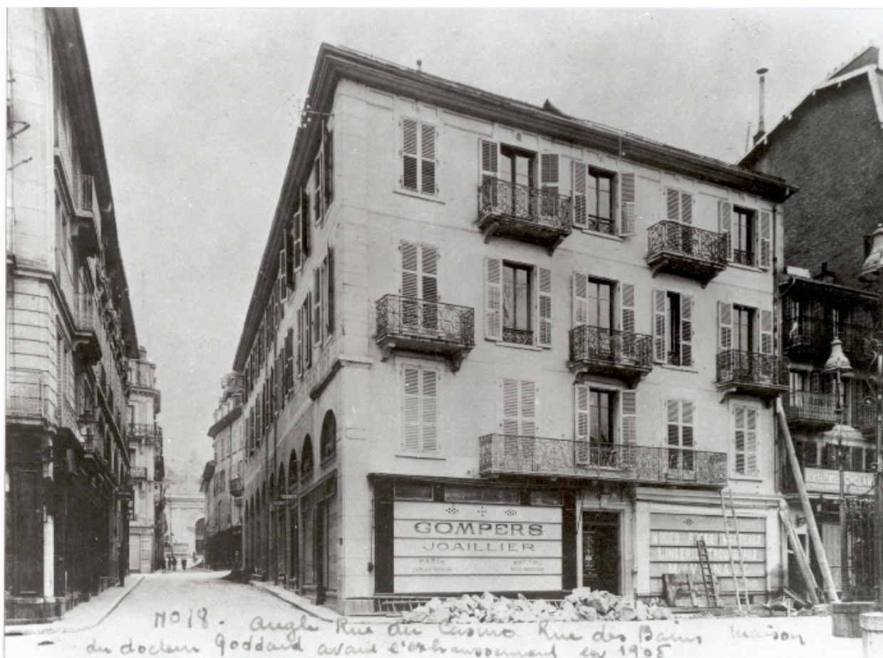
Façade, rue du Casino, avant exhaussement
